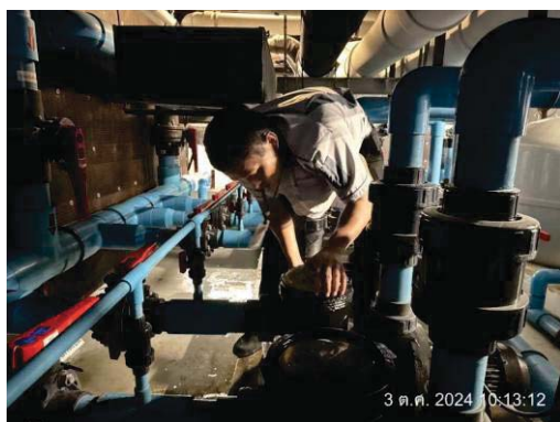
ตรวจสอบระบบกรองสรวายน้ำ
